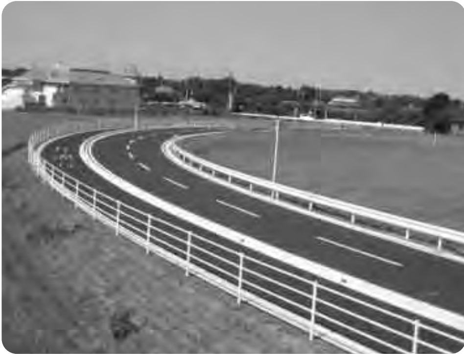
下之郷寺崎線、寺崎熊野神社付近
